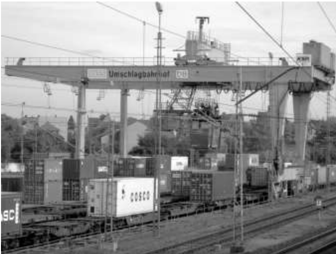
Abb.50: Alle für den Umschlag von Containern nötigen Komponenten gibt es schon. Noch werden sie aber in geringen Stückzahlen hergestellt. Das Containerzug-Liniennetz kann den entscheidenden Anstoß zur Serienproduktion geben, wodurch die Komponentenpreise sinken und die Exportchancen steigen.
